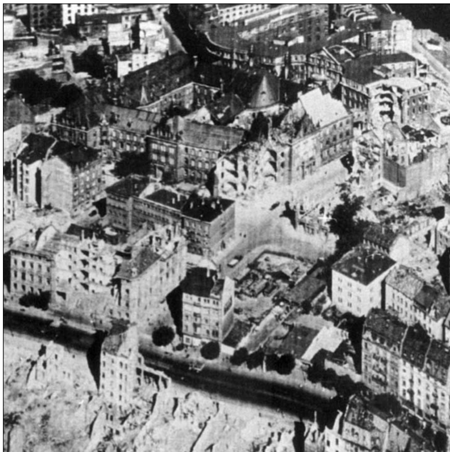
Luftaufnahme der östlichen Innenstadt, ca. 1945: In der Mitte der linken Bildhälfte ist das Polizeigefängnis zu sehen. Im Gegensatz zum alten Polizeipräsidium ist dieses nur leicht zerstört worden.
